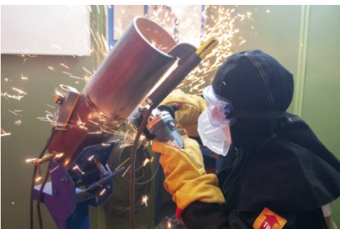
Проведение огнеопасных работ
